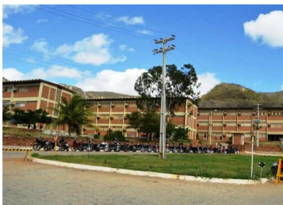
Figura 08 – Blocos de Salas de aula
