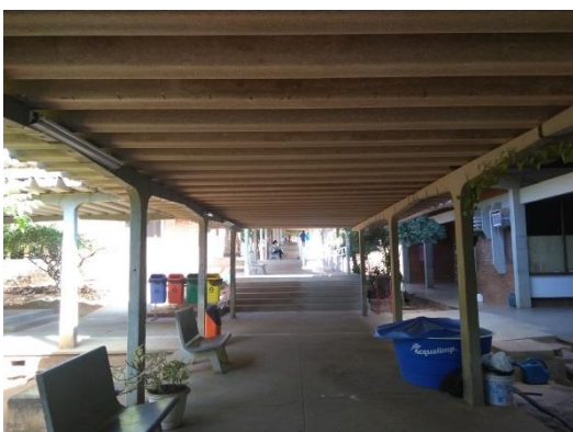
Figura 21 - Coberta em fibrocimento da passarela de ligação
