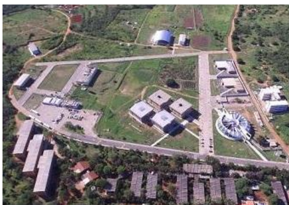
Figura 05 – Imagem aérea da Unidade
