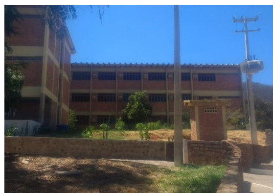
Figura 20 - Coberta em fibrocimento dos blocos de salas de aula
