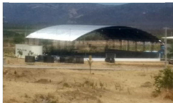
Figura 22 - Coberta em telha cerâmica dos blocos da pós graduação
