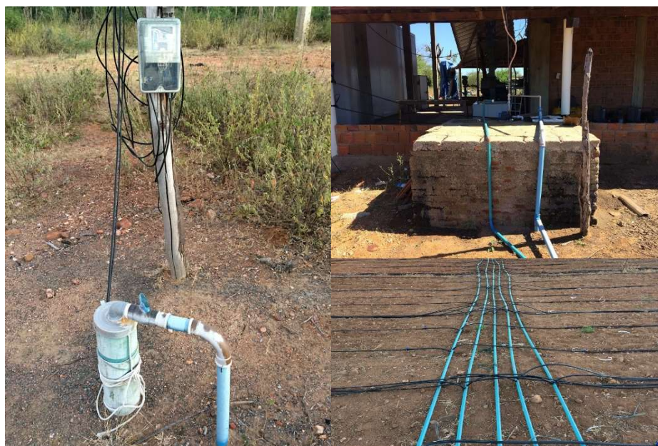
Figura 5. Captação, armazenamento e distribuição da água salobra utilizada no experimento.
