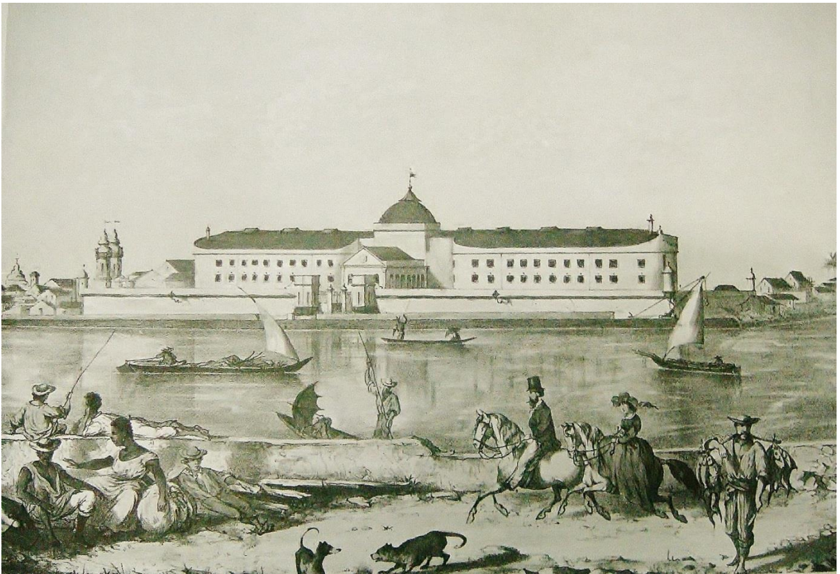
FIGURA 03: Casa de Detenção do Recife (Séc. XIX). Por Luís Schlappriz, 1863-1868.
