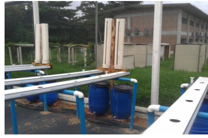
Figura 3. Eletrobomba de circulação (A) e abastecedor automático interligado a uma torneira boia (B)
