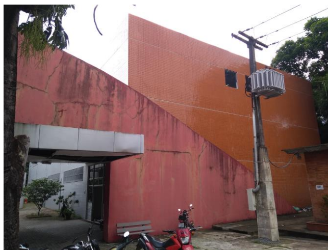
Figura 21 - Edifício sede do curso de Educação Física
