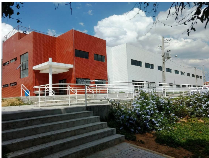
Figura 38 - Prédio de Tecnologia de Alimentos
