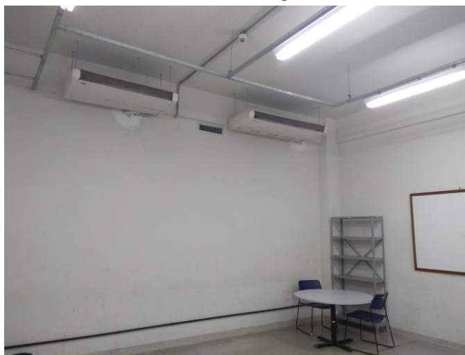
Figura 22 - Educação Física: climatização apenas onde necessária e uso exclusivo de lâmpadas fluorescentes
