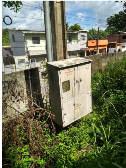
Figura 11 - CEGEN: sistema de medição individualizado de consumo de energia
