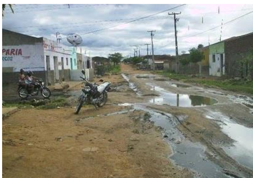
FIGURA 26 - Esgotos em uma das ruas de Barra do Rio
