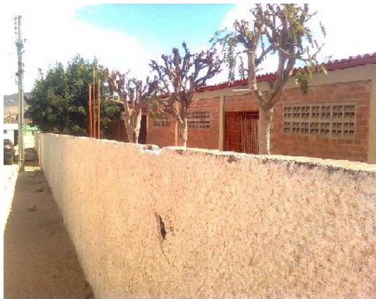
FIGURA 28 - Muro e fachada da Escola do Céu Azul
