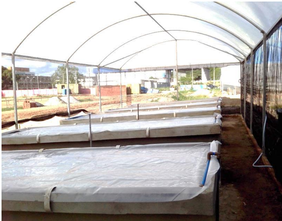
Figura 1. Casa de vegetação com cobertura de filme de polietileno transparente de 150 micras e telas nas laterais com sistema hidropônico de sub-irrigação, UFRPE, Recife-PE, 2015.
