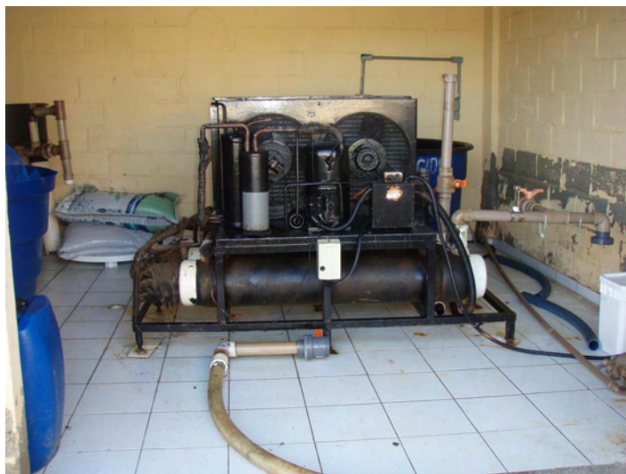
Figura 18. Resfriador ( chiller ) utilizado para controle de temperatura da água do tanque de reprodutores na Aqualider Maricultura Ltda. (Aqualider Maricultura Ltda.).
