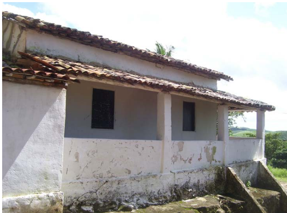
Foto 20 – Perspectiva da lateral esquerda da casa de moradia – Detalhe alpendre
