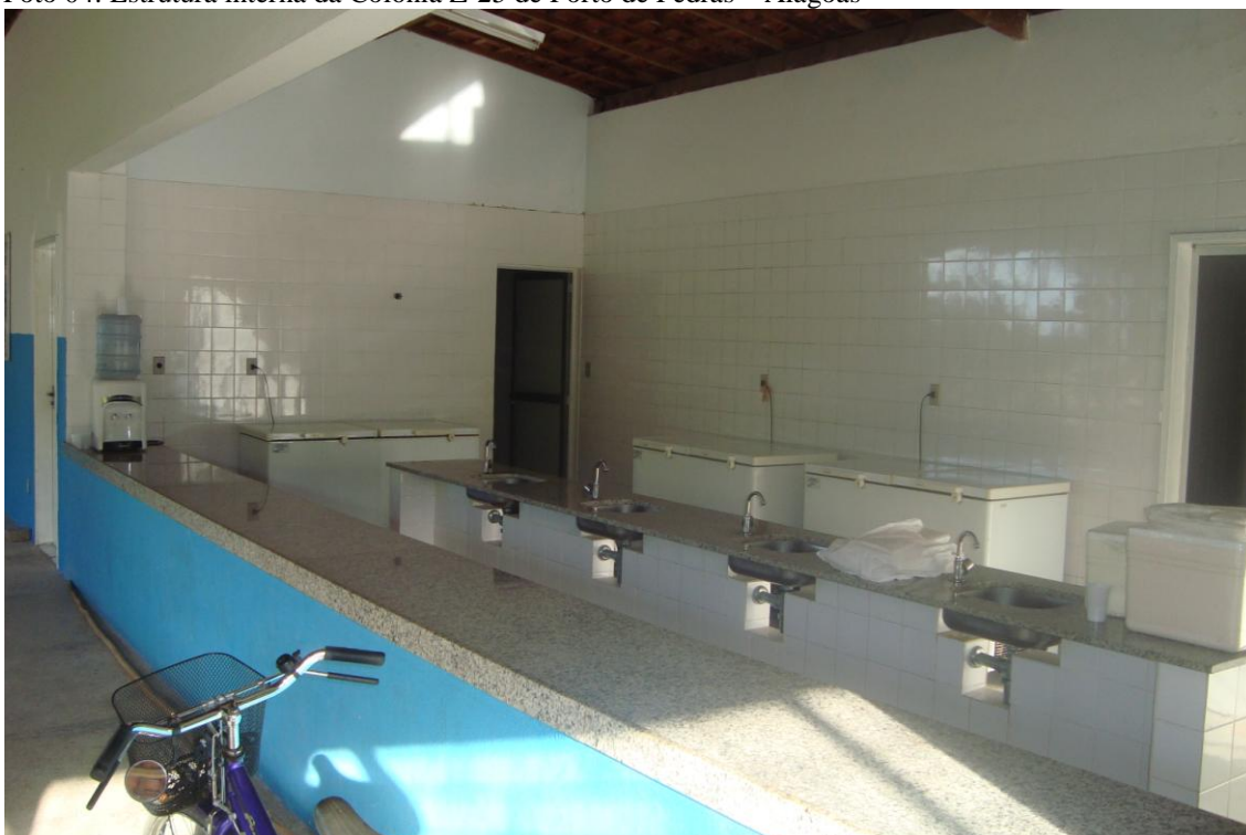
Foto 04: Estrutura interna da Colônia Z-25 de Porto de Pedras – Alagoas
