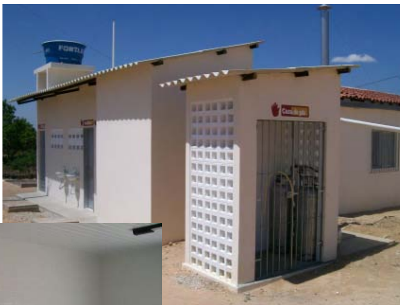
Banheiros e central de gás
