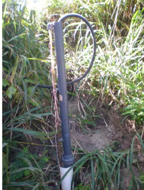
Figura 15. Coluna de PVC com altura de dois metros, para calibração do sensor.
