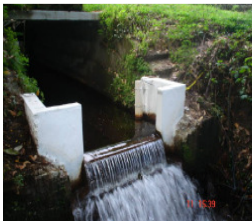
Figura 14. Vista parcial dos vertedores da seção retangular (A) e seção mista (B)
