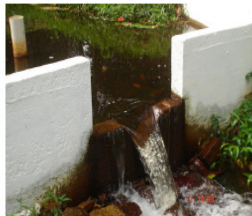
Figura 14. Vista parcial dos vertedores da seção retangular (A) e seção mista (B)
