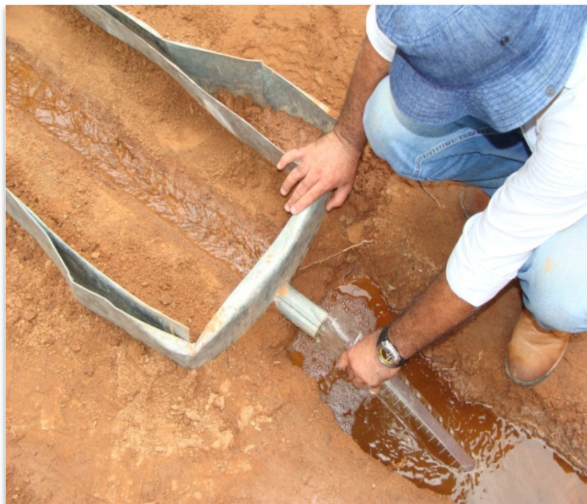
Figura 18. Calha coletora metálica para auxiliar na coleta da descarga líquida e sólida.
