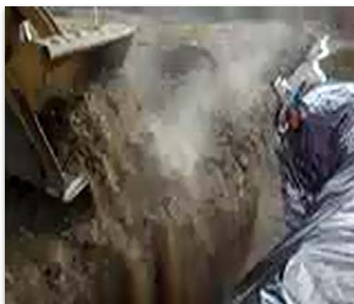
Figura 7. Aterramento da valeta da barragem subterrânea.
