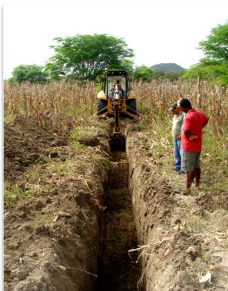
Figura 3. Barragem mostrando a abertura da valeta com a retro escavadeira.
