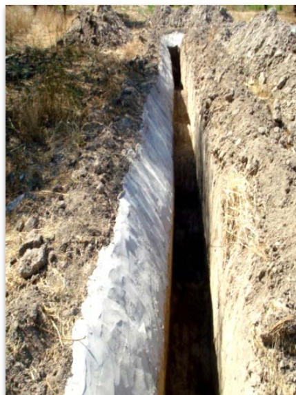
Figura 4. Área da barragem mostrando a valeta da barragem e o reboco de alvenaria.
