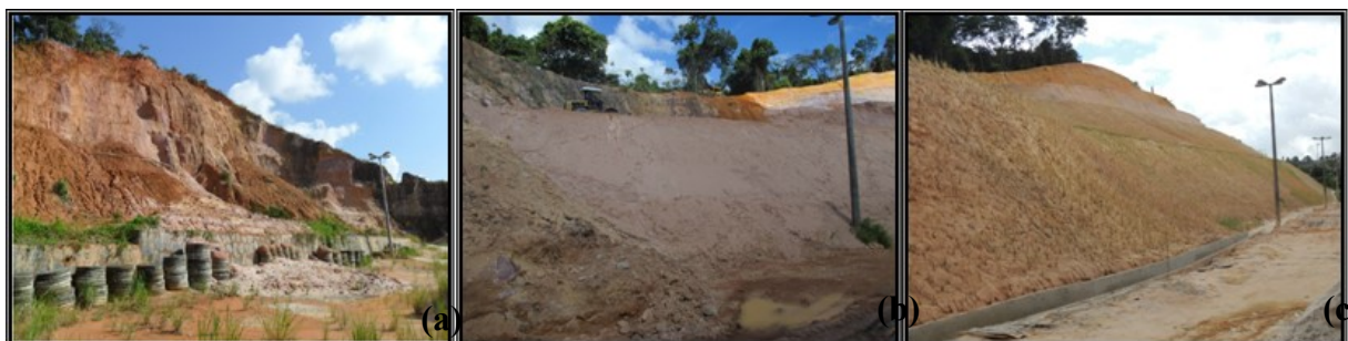
Figura 7. Evolução da RAD –(a) Encosta degradada antes da intervenção; (b) Retaludamento da encosta; (c) Encosta após a conclusão das obras
