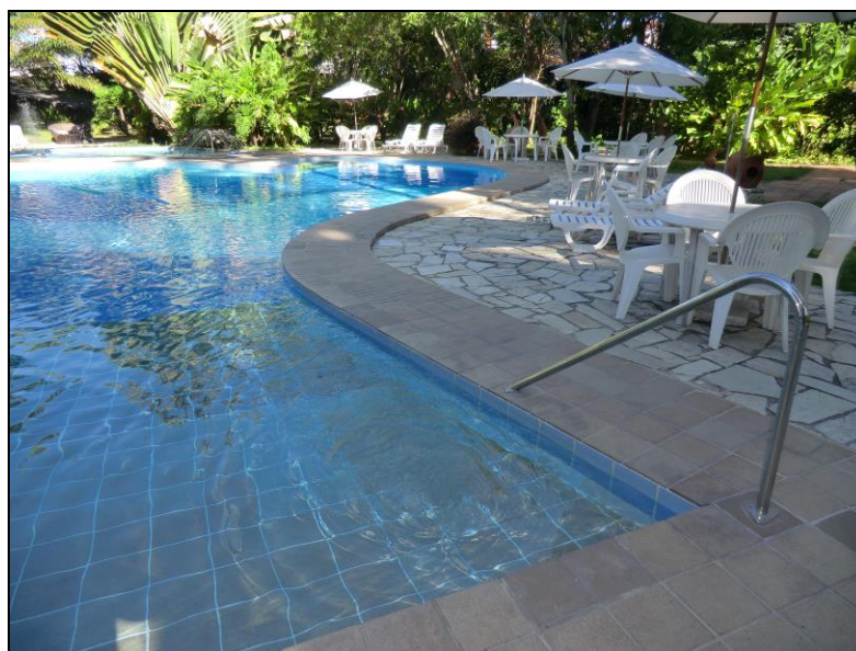
Figura 13 – Piscina com rampa submersa
