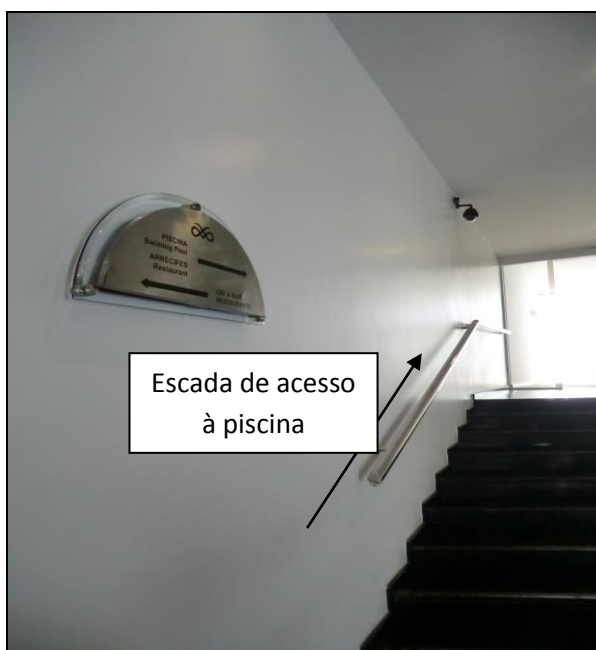
Figura 11 – Acesso à piscina com escadas
