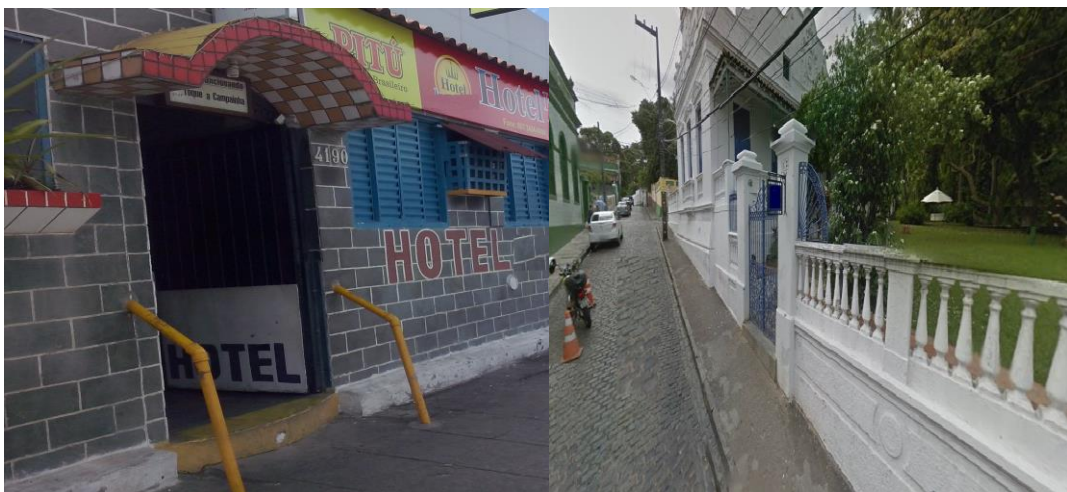
Figura 2 (esquerda) e Figura 3 (direita) – Inadequação das calçadas, obstáculo, ausência de rampa e piso tátil.
