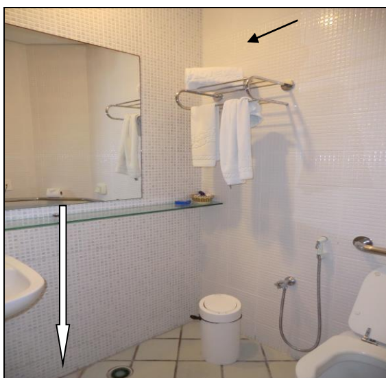
Figura 10 – Banheiro de hotel Uh com espelho e toalhas fora de alcance
