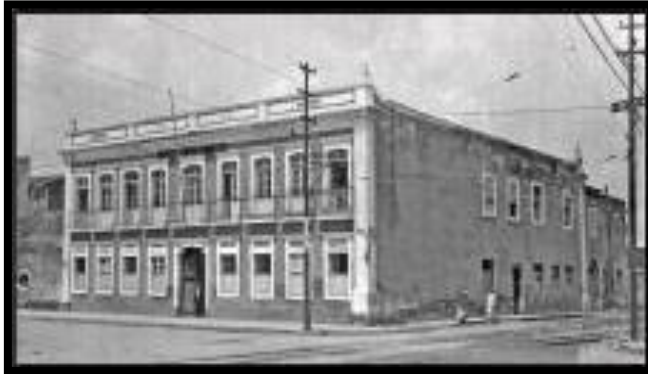
Imagem nº 03 Fachada do 1º Prédio da FDR, no Recife
