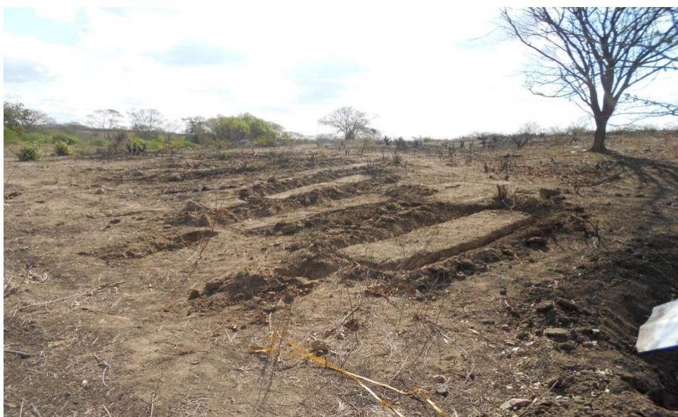
Figura 17. Vista parcial da área experimental durante a instalação dos blocos dos testes de erosão em sulcos na bacia hidrográfica do riacho Exu, Serra Talhada – PE
