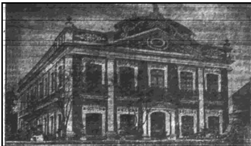
Ilustração 1 – Fotografia do Prédio da Escola de Belas Artes de Pernambuco localizado na rua Bemfica nº 150. Publicada no Diário de Pernambuco, 21 de Agosto de 1932.
