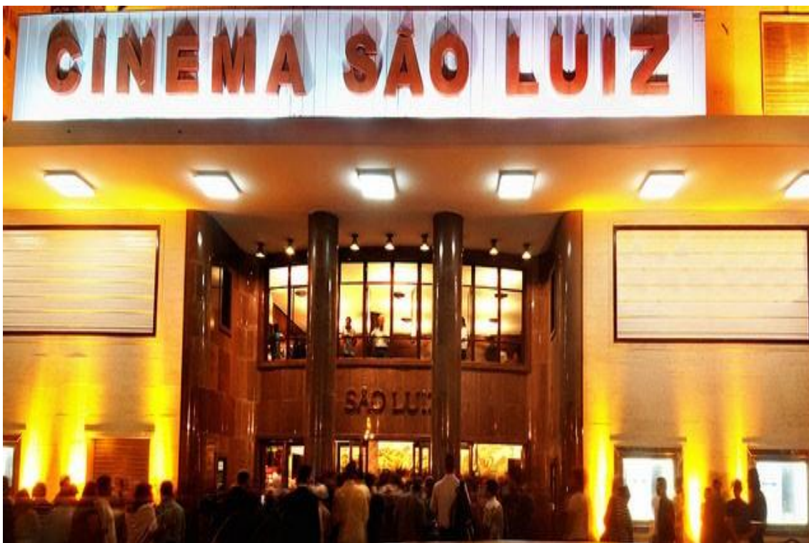
Figura 15 - Fachada do Cinema São Luiz após restauração no ano de 2008.
