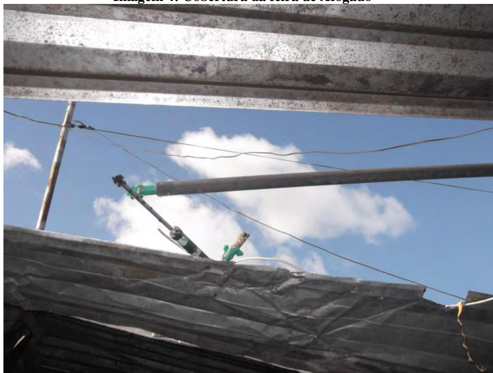
Imagem 4: Cobertura da feira de Afogado
