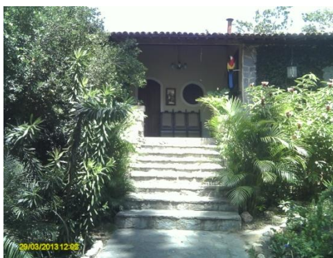
Figura 2 - Fachada Principal da Casa de Campo.
