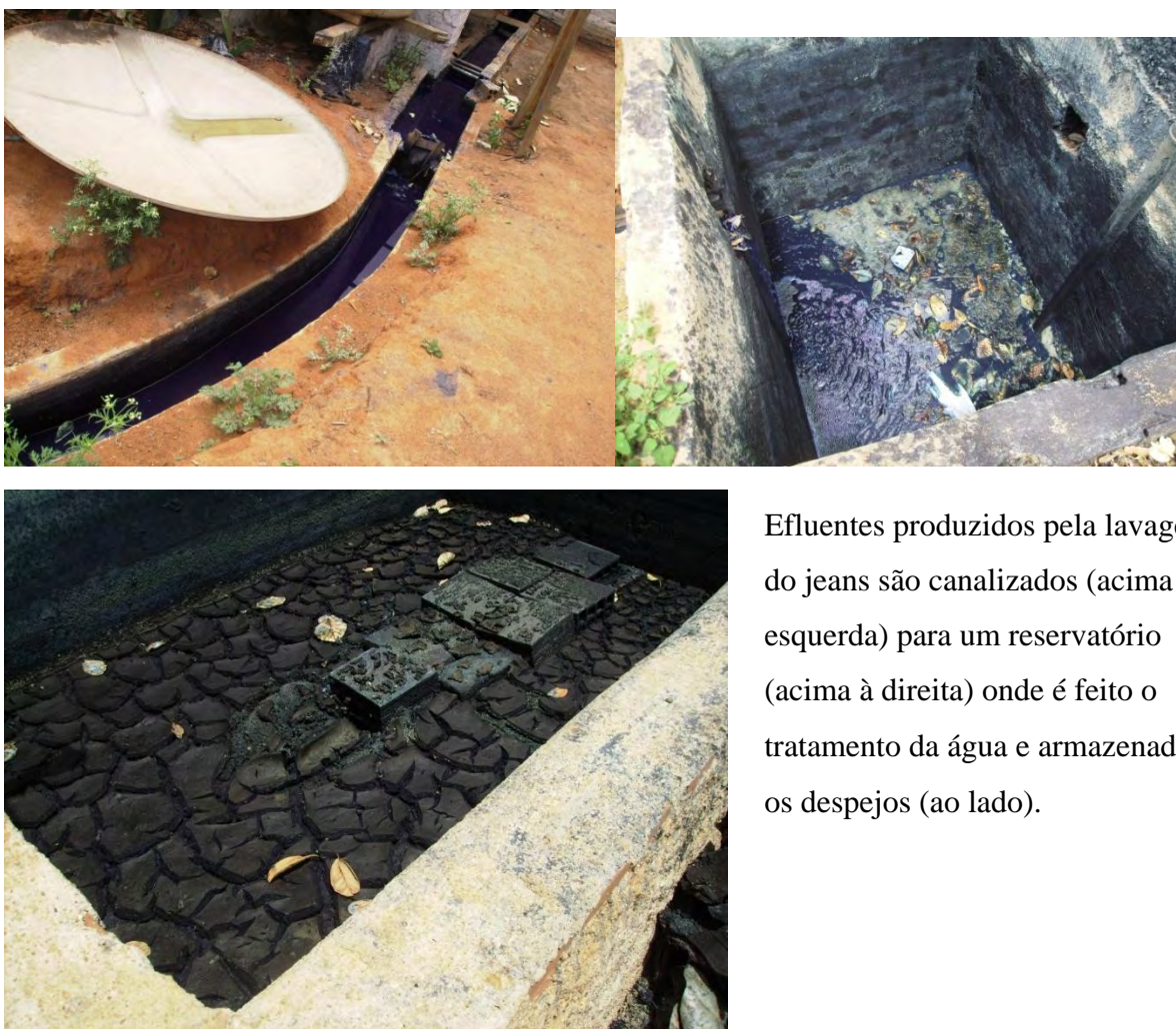
Figura VI - Reservatório onde a água resultante da lavagem é despejada.
