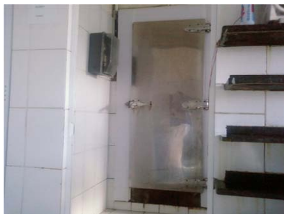
Figura 35. Câmara frigorífica para estocagem do queijo.
