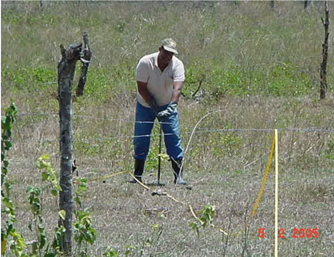
Figura 03 – Escavação utilizando trado em campo para locação dos piezômetros.
